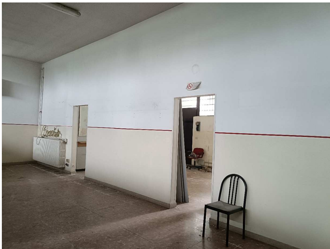
Locale 1 – vista su parete divisoria con locale 2
