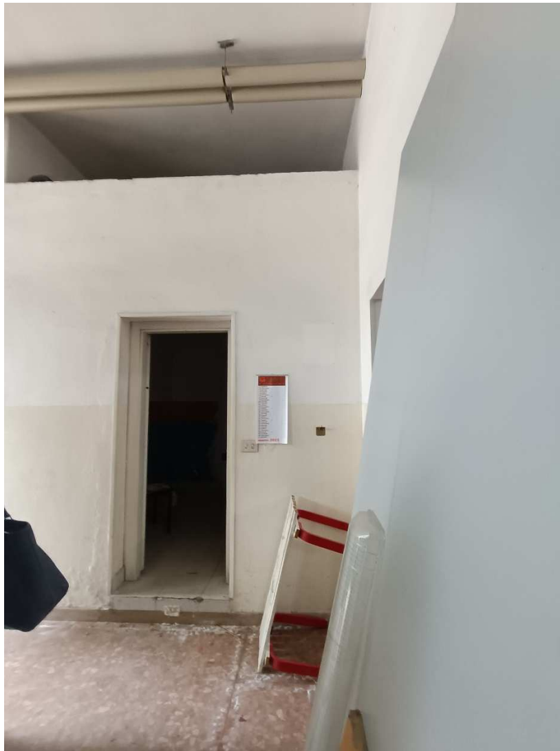
Locale 2 vista su ingresso vano cieco ( locale 4)
