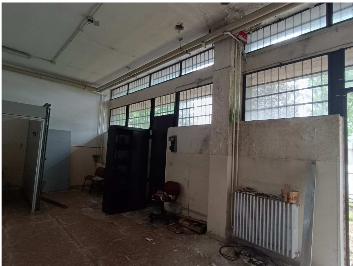
Locale 2 – parete porte ingresso secondario su area verde retro edificio
