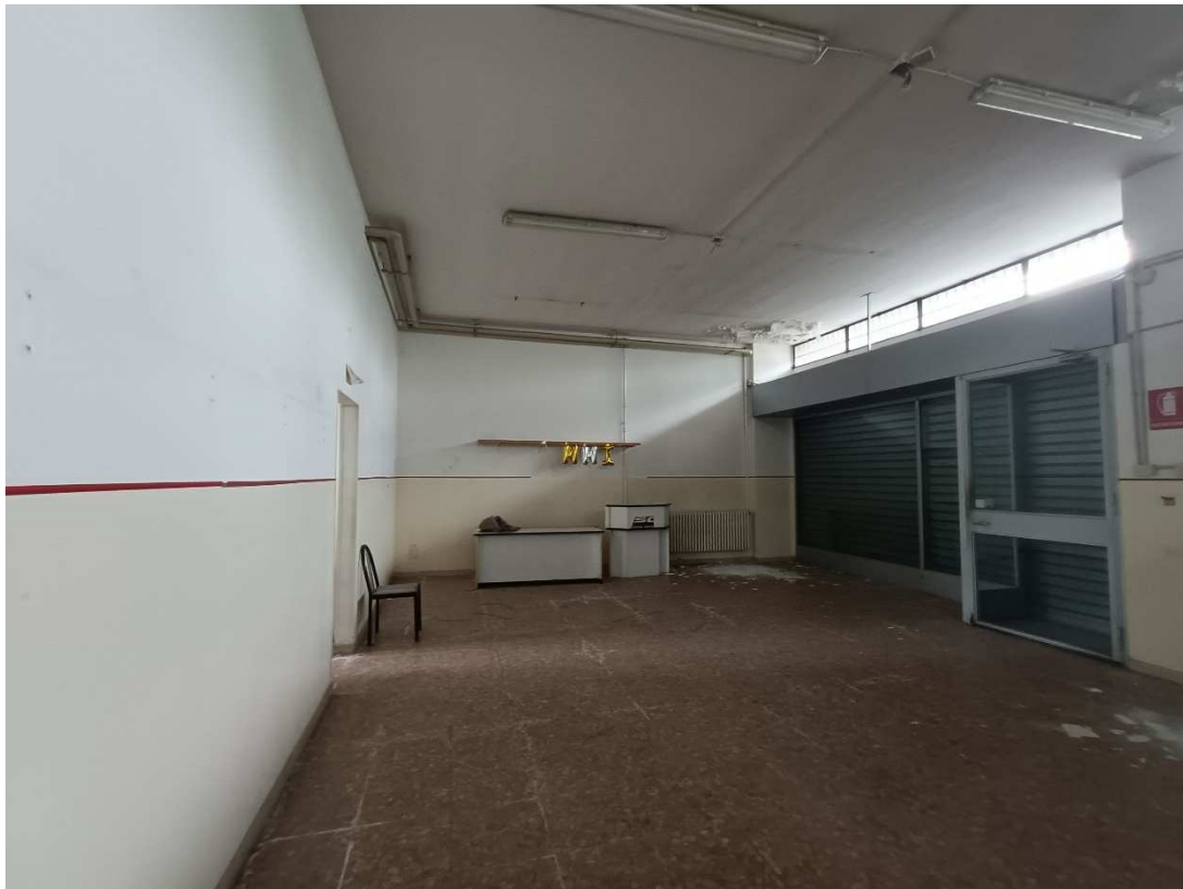
Locale 1 – vista su parete a confine con altra unità immobiliare
