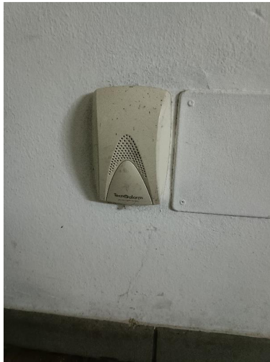
quadro elettrico e
