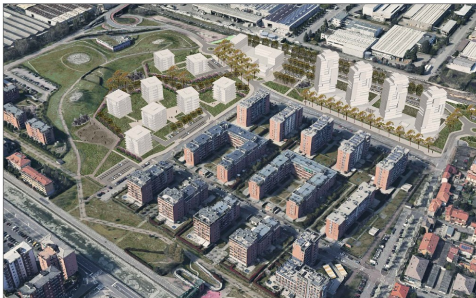
Figura 2: elaborati progettuali (vista area di intervento lato ovest)
