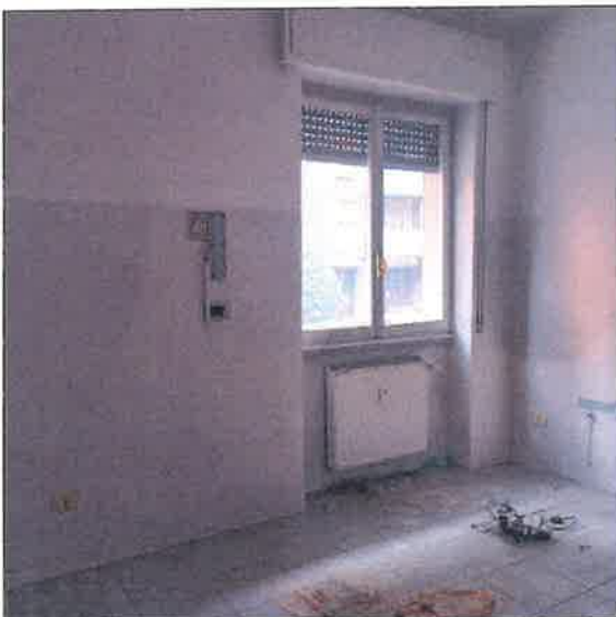
Interno con attacco a pavimento degli impianti medicali
